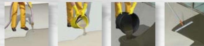
Capa base cementosa autonivelante para pavimentos.
