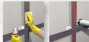
Fijación oculta mediante pegado de paneles ligeros en fachada ventilada.
