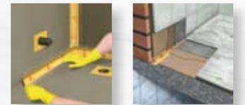
Banda impermeable para sellado de juntas en cuartos húmedos (compuesto por un sistema).
