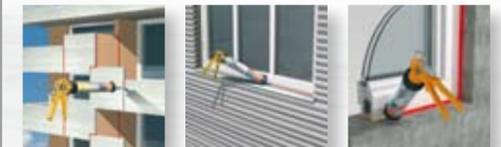
Sellado elástico e impermeable de juntas.
