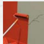
Tratamiento de protección anticarbonatación con puenteo de fisuras. Regulación y tapaporos.
