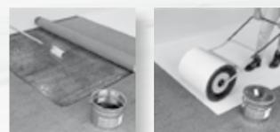
Membrana polimérica impermeable para cubiertas.
