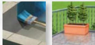
Revestimientos en los cuales se requiera flexibilidad, para puntear pequeñas fisuras.
