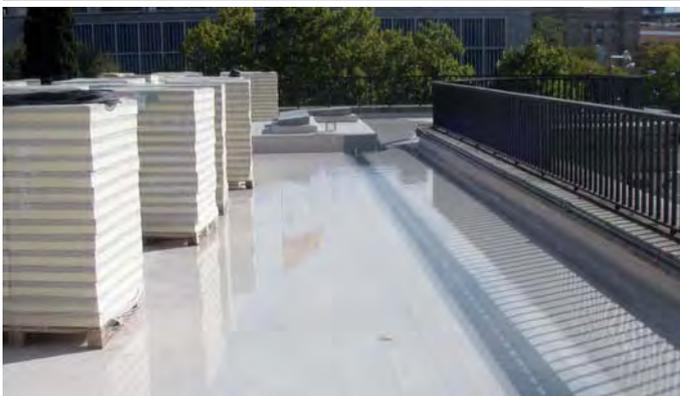
Opteimsa recibe el encargo de impermeabilizar la cubierta de la tercera planta del Ministerio de Medio Ambiente, Medio Rural y Marino en Madrid. Se opta por instalar un sistema de lámina de poliolefina flexible (FPO).
