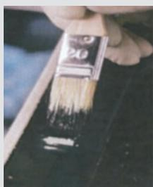
Después de activar, repare los posibles daños menores de la pintura causados al retirar el antiguo parabrisas, para ello utilice **Sika® Primer-206 G+P**. En caso de grandes áreas dañadas por favor póngase en contacto con su taller ó siga las especificaciones del fabricante del vehículo. Precaución: no pinte sobre los restos antiguos de poliuretano.
