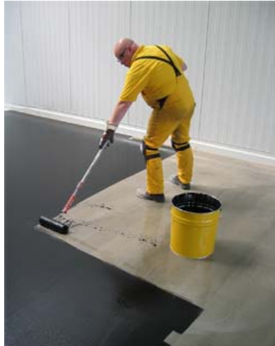
Aplicación de Sikafloor-220 W Conductive usando un rodillo de pelo corto.
