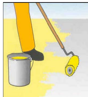
Aplicación de la capa lisa de imprimación Sikafloor-156/-161 y la capa conductiva Sikafloor 220 W Conductive: con rodillo de pelo medio/largo o brocha, p.e. rodillo o brocha Polyplan.
