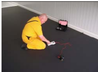
La conductividad de sikafloor 220 W Conductive debe ser ensayada y comprobada, antes de la aplicación de la siguiente capa.
