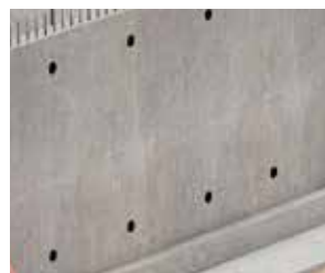
Anillos y Tapones SikaSwell® Sikadur® 31 Sellado de los espadines
