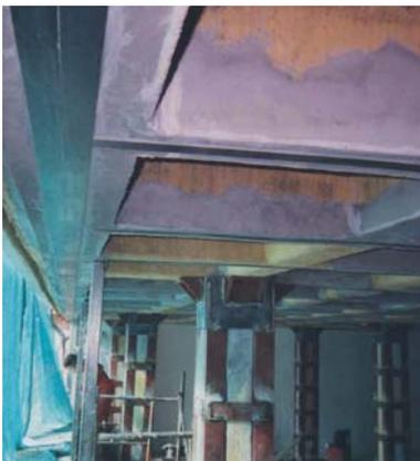
Impermeabilizaciones Safer, enmarcada dentro de las actuaciones de la constructora Construcciones Sebastián Fernández, ha llevado a cabo la reparación y protección de la estructura de hormigón en el edificio del Rectorado mediante el empleo de morteros de reparación de la gama Sika Monotop y la aplicación de Sika Carbodur, sistema de refuerzo de estructuras a base de pegado de laminados de carbono.
