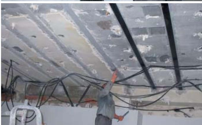
Probasur llevó a cabo en primer lugar la limpieza de la zona a tratar con fresadora provista de disco de diamante, para a continuación reparar los desperfectos con Sikadur 31. Finalmente se realizó el refuerzo con Sika Carbodur 812 S, pegado con la resina Sikadur 30. Se utilizaron un total de 3.700 metros lineales.
