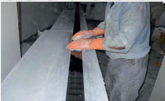
El refuerzo a flexión se resuelve con la colocación en la cara inferior de las vigas, previo recálculo estructural, de la cuantía de armadura de refuerzo necesaria en forma de laminados de fibra de carbono adheridos con resina epoxi Sikadur 30.
