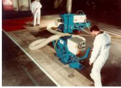
Limpieza con granalla o chorro de arena
