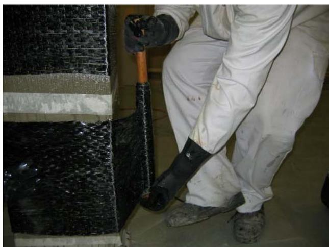
Si se requieren capas adicionales se repetirá el proceso de impregnación y laminación.
