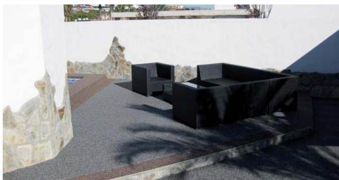
La empresa DAT Interior Design realiza en una vivienda particular la ejecución de un pavimento en piedra de mármol triturada en varias medidas y mezclada con epoxi. Esta especialidad, llamada "Stone Carpets", es una exclusiva tecnología de suelos
