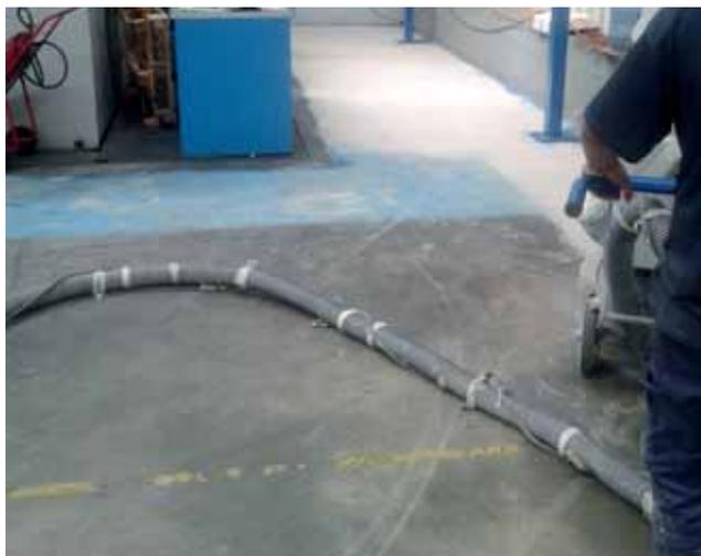
de la resina. Una vez preparado el soporte, procedemos a la imprimación del mismo con resinas epoxi (Sikafloor®-160) con una buena penetración y sellado del soporte. Aplicación de mortero autonivelante a base de resinas epoxi (Sikafloor®-264) con lo que conseguimos un soporte regularizado, liso y un acabado adecuado a las necesidades del cliente.
