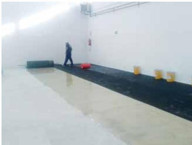
continuo y sin poros. Aplicamos a continuación, respetando los tiempos de curado, el autonivelante totalmente elástico (Pulastic GM 1.500) lo que nos da un soporte liso y uniforme, dándole al sistema esa elasticidad que lo hace tan cómodo en su uso junto al caucho. Por último le aplicamos 2 manos cruzadas de revestimiento (Pulastic Coating-221) que le da ese acabado mate sedoso que le aporta una textura antideslizante y estética.
