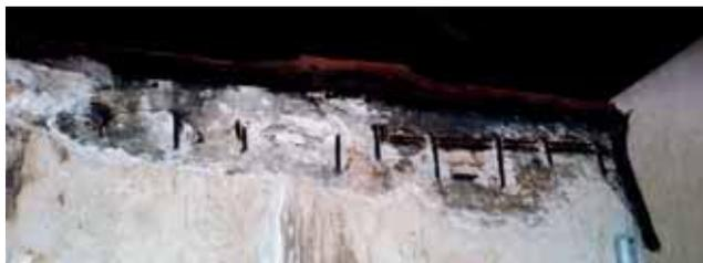
En este caso cabe remarcar la excepcional laborar de los trabajos de regeneración de superficies con mortero sobre todo en las impostas ya que al ser un elemento artístico de especial interés, se ha tratado de mantener el diseño original llevando a cabo la preparación de moldes especiales siendo necesarias en torno a 30 toneladas de SikaRep®-414.
