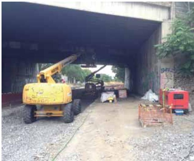
Se aplicó por toda la superficie de estructura del tablero una protección inhibitora de corrosión con Sika® FerroGard®-903.
