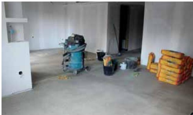
Tras el secado del mortero autonivelante se procede a la aplicación de una capa de Sikafloor<sup>®</sup>-161 como puente de unión entre el autonivelante cementoso y el autonivelante de resina.
