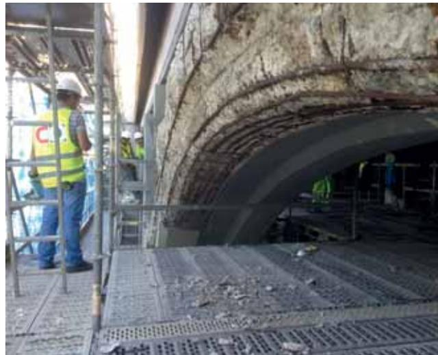
En el tablero, se realizaron taladros en el fondo del tablero aligerado para vaciar de agua los aligeramientos, sellando los drenajes de PVC con Sikaflex®-11 FC+, y se realizó la impermeabilización del tablero para evitar nuevamente la entrada de agua. Se ejecutaron nuevamente las juntas de dilatación de calzada y se sellaron las juntas de acera utilizando un Fondo de Junta Sika de espuma de polietileno sobre el que se aplicó el sellador de altas prestaciones para pavimentos Sikaflex® PRO-3.
