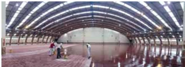
Imprimación del pavimento: Aplicación de una capa de imprimación de resina epoxi de 2 componentes Sikafloor®-161 sobre toda la superficie del pavimento.
