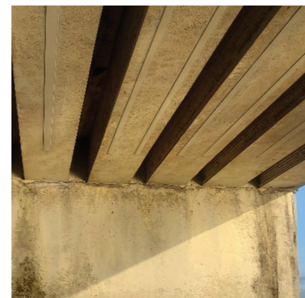
La parte inferior de las vigas presenta un buen aspecto. Salvo en alguna zona muy puntual, el aspecto en todas las vigas es como en la foto.
