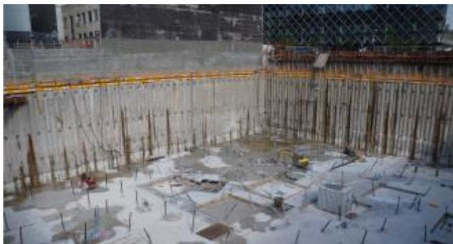
Excavación vertical. Por ejemplo, muros pantalla
