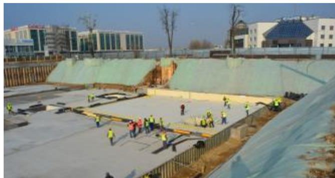
Excavación con taludes
