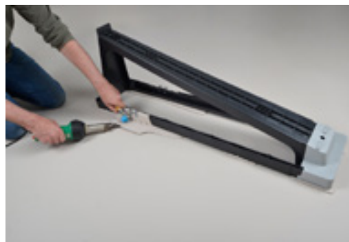
Soldadura con aire caliente del Sika® SolarClick
