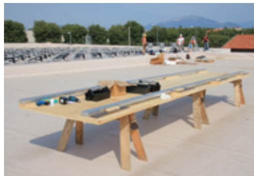
Preparación de los componentes del sistema en un banco de trabajo
