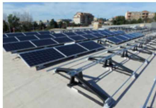
Instalación en progreso
