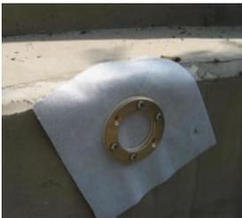
Para las tuberías y desagües existen accesorios que se aplicarán de la misma forma que Sika® SealTape F. Ver documentación técnica de Sika® SealTape F.
