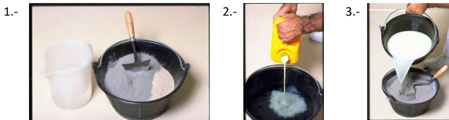
Mezclar el cemento y arena con la solución de **SikaLatex**<sup>®</sup> y agua hasta llegar a una consistencia aplicable con brocha. Aplicar el puente de unión utilizando una brocha de pelo duro o por proyección. Aplicar la lechada presionando con fuerza para que penetre en los poros.
