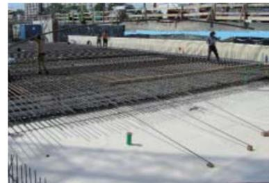
Debido a los requisitos de pegado total y continuo, la armadura debe colocarse cuidadosamente sobre la membrana utilizando separadores apropiados.
