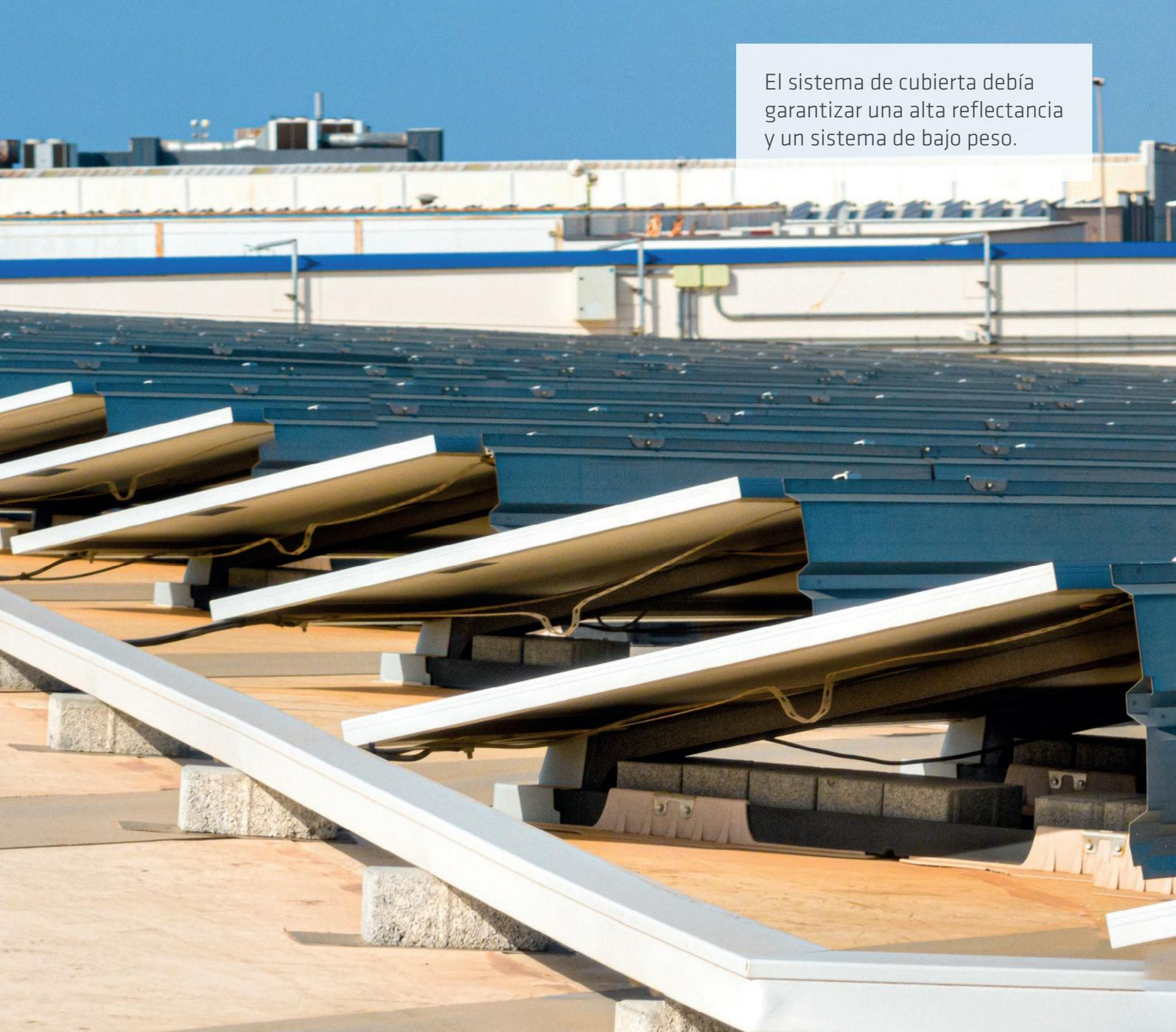
El sistema de cubierta debía garantizar una alta reflectancia y un sistema de bajo peso.
