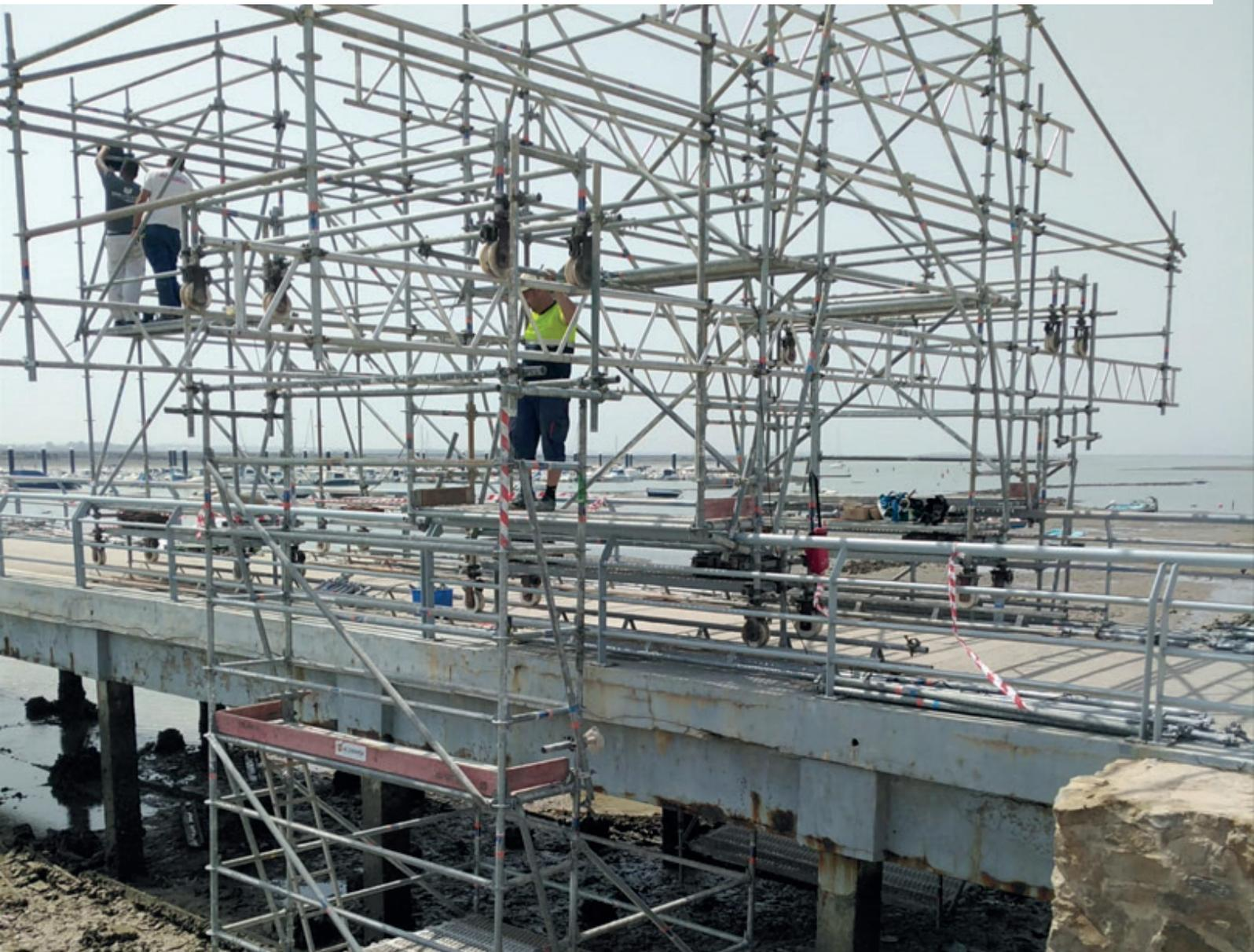
Los requerimientos de la obra comenzaban con un saneado exhaustivo de la estructura mediante hidrodemolición manual y robotizada hasta los 2.500 bar, tanto a lo largo de la cara inferior del tablero como de los laterales, así como de las vigas de arriostramiento de los pilotes. A continuación y sobre el saneado de la estructura completado, se requería llevar a cabo la reparación, el refuerzo y la protección de la estructura.
