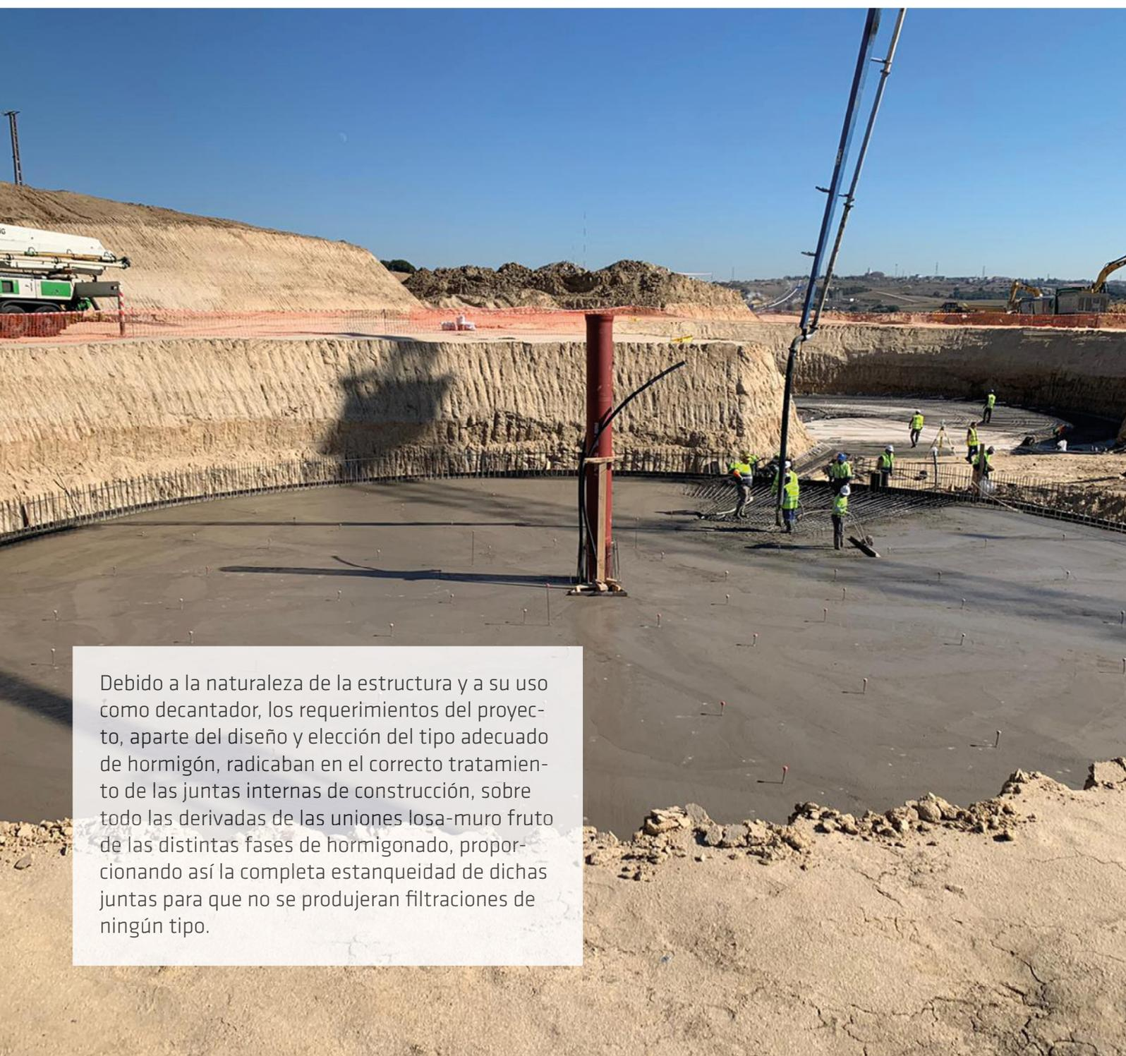
Debido a la naturaleza de la estructura y a su uso como decantador, los requerimientos del proyecto, aparte del diseño y elección del tipo adecuado de hormigón, radicaban en el correcto tratamiento de las juntas internas de construcción, sobre todo las derivadas de las uniones losa-muro fruto de las distintas fases de hormigonado, proporcionando así la completa estanqueidad de dichas juntas para que no se produjeran filtraciones de ningún tipo.
