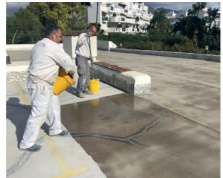
Aplicación de imprimación SikaFloor®-161 seguida de sembrado de árido Sikadur®-510
