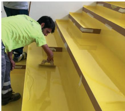
Sin embargo, el pavimento preexistente no estaba a la altura, ya que se trataba de un suelo de hormigón con un tratamiento de pintura mal ejecutado que había que eliminar y sustituir.
