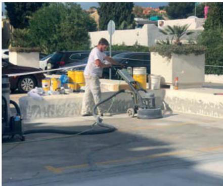
Lijado mecánico de la superficie con disco de diamante
