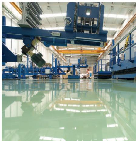
En la zona de laboratorio y control de calidad, además de un pavimento con escasa planimetría, había dos grandes juntas de dilatación que dificultaban el movimiento de las grandes cargas que suponen los trafos, y aumentaban los costes de mantenimiento de los vehículos transportadores por colchón de aire.
