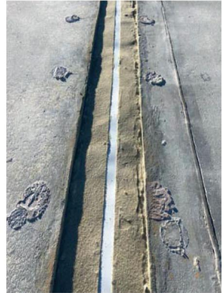
Tratamiento de las juntas de dilatación con el sistema Sikadur® Combiflex SG
