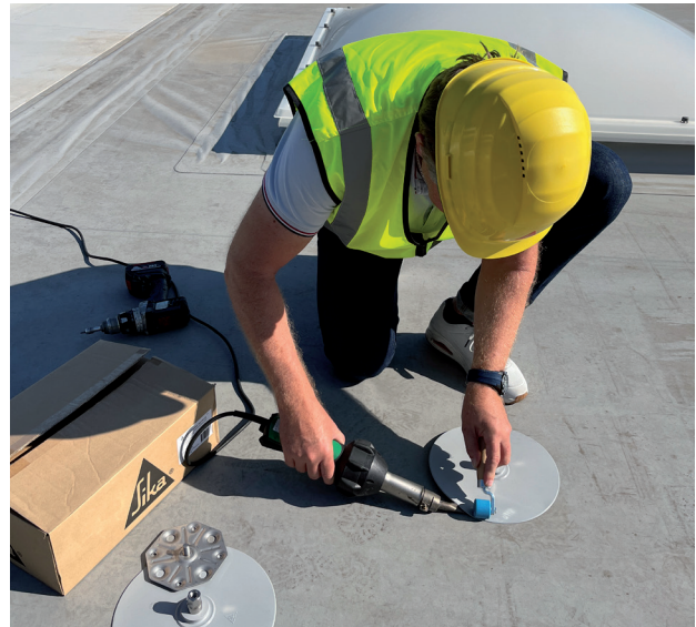
Anclaje SikaRoof® 250 mm CR atornillado a la arandela SikaRoof® de anclaje de 140 mm y soldada con aire caliente a la membrana impermeabilizante de la cubierta.
