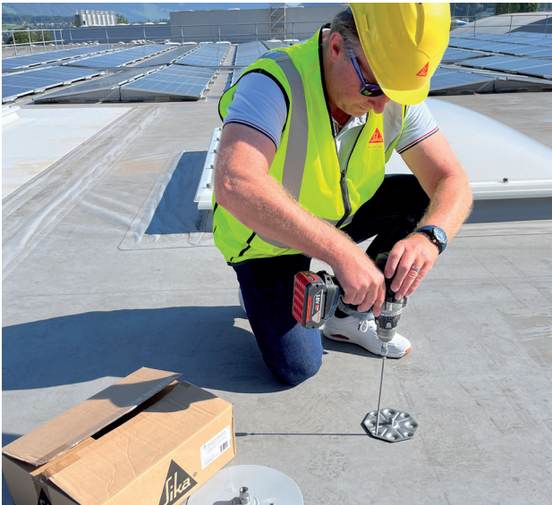
Fijación Sarnafast® SBF-6.0 o, alternativamente, Sarnafast® Fijación SBF-6.0 con tubo Sarnabar® SBT-20
