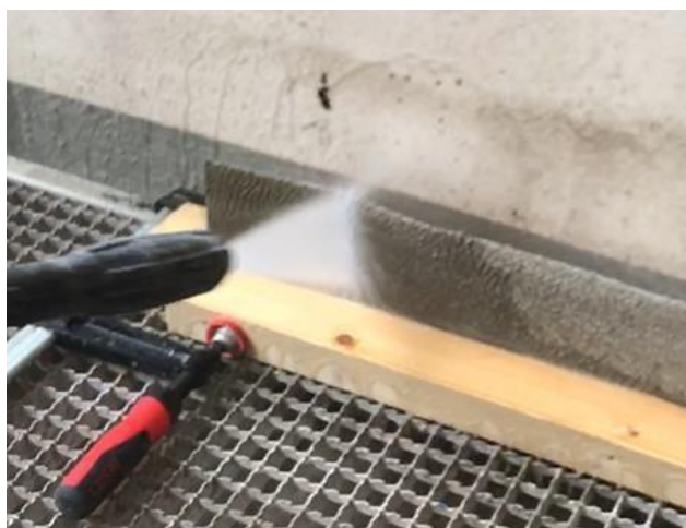
Figura 9 Limpieza de Sika Waterbar® FB-125 mediante chorro de agua.
