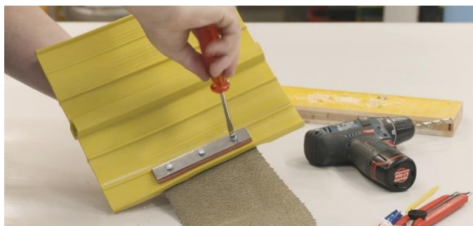
Figura 7 Ajuste de la unión entre la Sika Waterbar® FB-125 y la Sika Waterbar® Tipo D (PVC).
