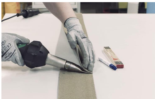
Figura 3 Soldadura Sika Waterbar® FB-125 mediante unión térmica.
