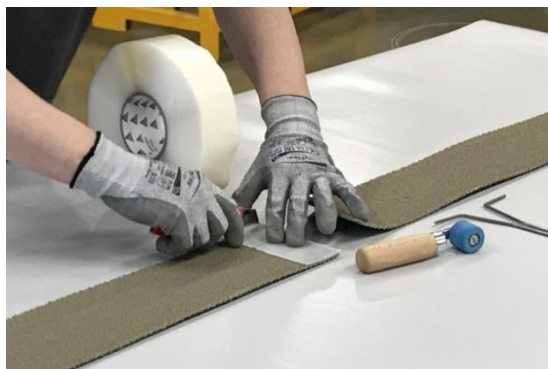
Figura 5 Sika Waterbar® FB-125 unión mediante cinta.
