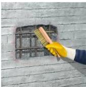
El acero deberá estar completamente limpio y libre de óxido, incrustaciones, mortero, hormigón, polvo, y otros materiales sueltos que reduzcan la adherencia o contribuyan a la corrosión. Otros elementos como clavos también deben ser retirados.
