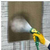
Los morteros de protección, regularización y revestimiento se pueden aplicar manualmente o mediante pistola de pintor para grandes superficies. Consulte la hoja de datos del producto correspondiente para obtener más información.
