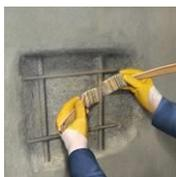
Cuando se requiera una protección contra la corrosión del acero, se aplicará el producto en toda la superficie de la barra, en dos capas. Espere hasta que la primera capa esté seca antes de aplicar la segunda. Utilice un espejo para inspeccionar la parte de atrás de la barra, y así garantizar que se aplica sobre toda la superficie.
