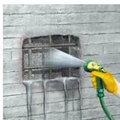
Las superficies de hormigón se saturarán con agua limpia a baja presión durante un mínimo de 2 horas antes de la aplicación, asegurando que todos los poros y huecos estén adecuadamente húmedos. La superficie no se debe dejar secar antes de la aplicación.
