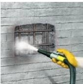
Toda la circunferencia de la barra deberá limpiarse uniformemente, excepto cuando las consideraciones estructurales lo impidan. La limpieza no debe dañar de ninguna manera la integridad estructural del acero. Se deberá notificar inmediatamente al Técnico correspondiente si existe la posibilidad de dañar el acero mediante la limpieza.
