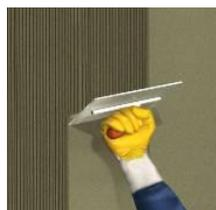
Cuando la primera capa haya endurecido, aplíquese la segunda capa entre las líneas verticales. La dureza se puede comprobar mediante la facilidad con que se puede insertar un clavo en el mortero.
