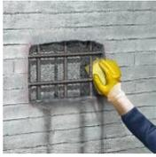
Justo antes de la aplicación se deberá eliminar el exceso de agua, por ejemplo, empleando una esponja para áreas pequeñas o aire comprimido para grandes áreas. Asegúrese de que no haya agua estancada en la superficie. La superficie deberá alcanzar un aspecto mate oscuro sin brillar, y los poros superficiales y los huecos no deberán contener agua (superficie saturada seca). Utilizar aire comprimido (libre de aceite) para eliminar el exceso de agua en áreas de difícil acceso.
