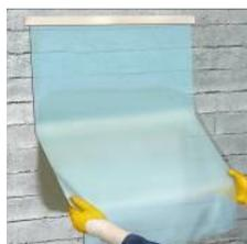
Se deberá realizar el curado mediante las técnicas apropiadas durante los 3 días posteriores a la aplicación, o bien pulverizar agua una vez que se haya evaporado el agua superficial. El curado se realizará mediante agua o empleando láminas o membranas adecuadas.
