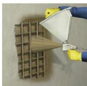
Consulte en la hoja de datos del mortero de reparación correspondiente si requiere una imprimación previa para la unión. En ese caso, la superficie del soporte debe ser previamente humedecida de acuerdo con la sección 6.3.
