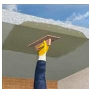
El mortero de reparación debe presionarse firmemente en la zona que se va a reparar, siempre sobre un soporte perfectamente preparado. Asegúrese de que todos los poros y los huecos del soporte estén llenos.
