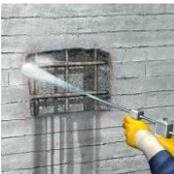
Las barras contaminadas con cloruros u otro material nocivo deberán limpiarse mediante chorro de agua a baja presión (18 MPa), y verificarse posteriormente para comprobar que la contaminación ha sido totalmente eliminada.
