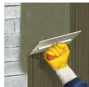
Se aplicará una capa sobre toda la superficie de hormigón preparada (incluyendo zonas reparadas y no reparadas). Cualquier lechada superficial se eliminará previamente (Sección 6.1) y se humedecerá de acuerdo con la sección 6.3.
