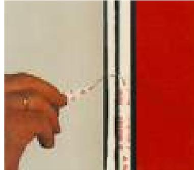
El panel se coloca sobre la fachada con ayuda de ventosas. Los paneles se colocan apoyándose en espaciadores que determinan la junta entre paneles o sobre calzos que definan la horizontalidad de la primera fila de paneles. Cuando la posición del panel es la correcta se presiona fuertemente contra la Cinta SikaTack® Panel 3 con el fin de que ésta lo sujete mientras polimeriza el adhesivo.
