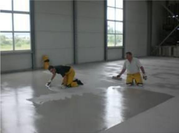
Distribuir el producto de una manera uniforme sobre la superficie compactada, utilizando para ello una llana metálica que se apoye sobre la arena de cuarzo que sobresalga. Es una aplicación para ser realizada de rodillas.
