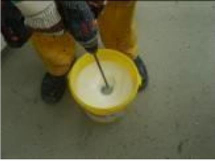
Comprobar que en el mezclado no aparecen grumos en las aspas de la batidora. Para asegurar un perfecto mezclado, cambiar de recipiente, y mezclar nuevamente.
