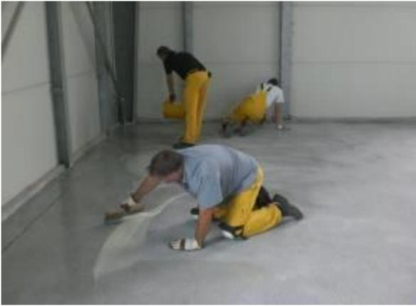
Distribuir el slurry de una manera uniforme sobre la imprimación, apoyando la llana metálica, para ello, sobre las crestas de la arena de cuarzo de que se había espolvoreado.
