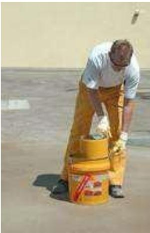
Asegurarse de que el componente A ha sido vaciado totalmente sobre el B
