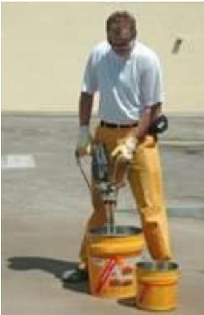
Mezclar ambos componentes con una batidora de bajas revoluciones (300-400 r.p.m.) durante al menos 3 minutos, hasta conseguir una mezcla uniforme
