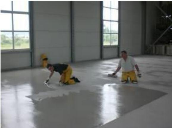
Distribuir el producto de una manera uniforme sobre la superficie compactada, utilizando para ello una llana metálica que se apoye sobre la arena de cuarzo que sobresalga.
