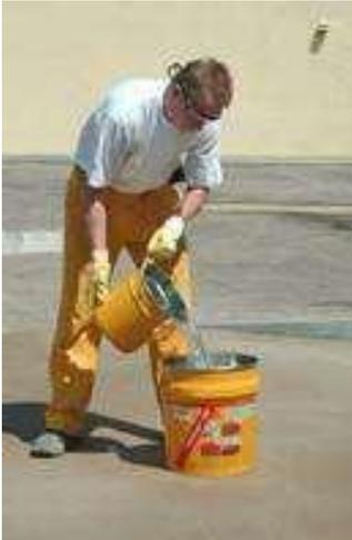
Antes de mezclar, remover el componente A (resina) y posteriormente añadir sobre el componente B
