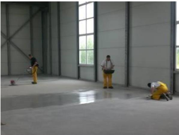
Asegurarse de que la aplicación del slurry, el espolvoreo posterior y el compactado mecánico se hacen inmediatamente uno detrás de otro.
