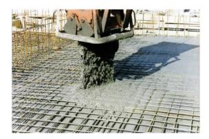
La calidad del hormigón es un factor clave para un eficaz y duradero sistema de impermeabilización. Permite una solución de adhesión completa y permanente, sin ningún flujo lateral de agua o migración entre la membrana **SikaProof® A+** y la estructura de hormigón.
