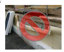
¡Prestar atención al encofrado y a las fases de hormigonado entre losas para prevenir cualquier punzonamiento/daño en la membrana!
