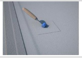
Corte o daño de la membrana superior a 10 mm (d > 10 mm): Sellar y pegar la membrana SikaProof® A+ y SikaProof® Tape A+
