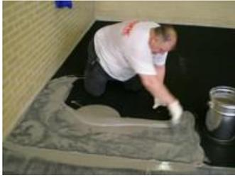
El Sikafloor® - Comfort Porefiller se vierte y reparte uniformemente usando una llana dentada, de rodillas.
