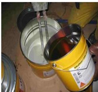
Mezclado de Sikafloor®-Comfort Adhesive y Sikafloor®-Comfort Porefiller.
