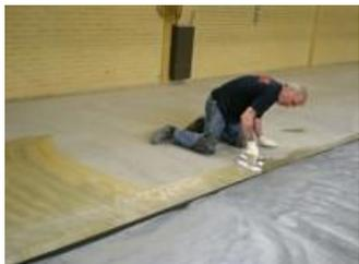
El Sikafloor®-Comfort Adhesive se vierte y reparte uniformemente usando una llana dentada, de rodillas.
