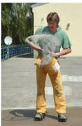
Cuando se crea que se van a superar los tiempos máximos de espera, espolvoree ligeramente con arena de cuarzo secada al horno de (0.4 - 0.7 mm) hasta un máximo de 1.0 kg/m<sup>2</sup>.
