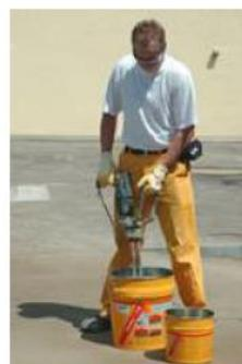
Mezcle ambos componentes a fondo con un agitador eléctrico de baja velocidad (300 - 400 rpm).
