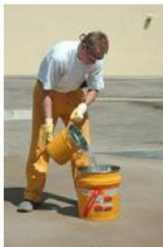
Antes de mezclar, agite el componente A (resina) y añada todo el componente B (endurecedor).
