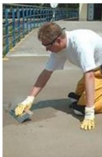
Aplicación de la capa de igualado con lana / rastra de goma al espesor requerido – de rodillas o bien ...
