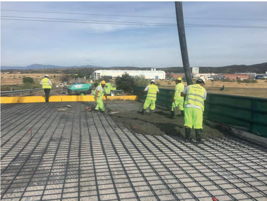
Nueva solera de hormigón armado
