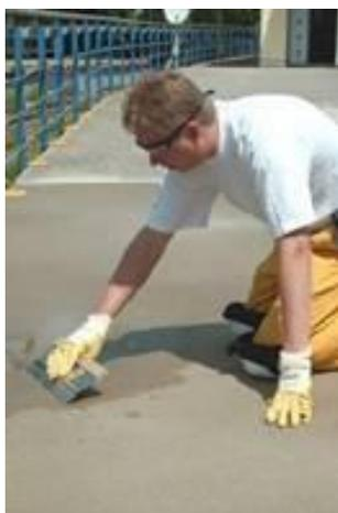
Aplicación de la capa de raspado mediante llana de goma o metálica dependiendo del espesor de la capa – arrodillado o...
