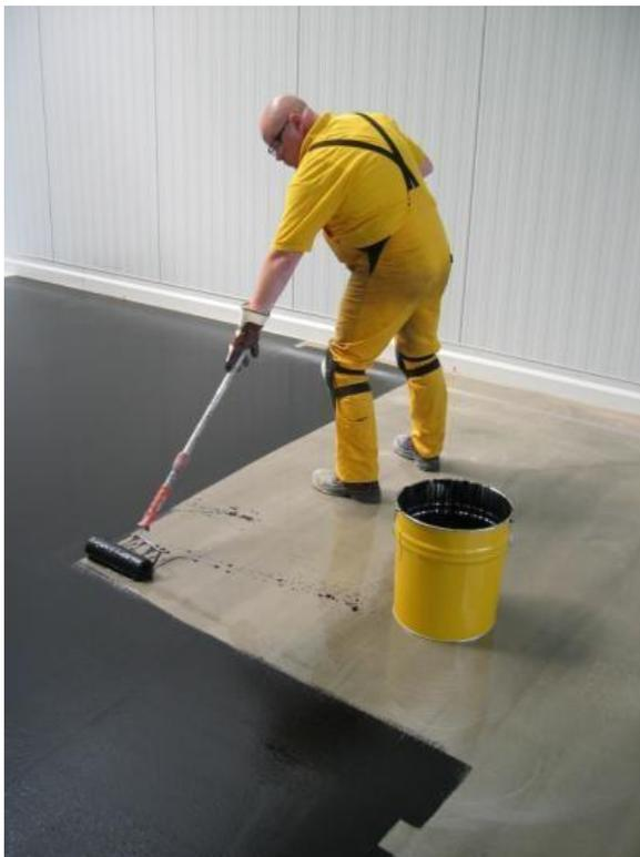
Aplicación del Sikafloor®-220 W Conductive por medio de un rodillo de pelo corto.
