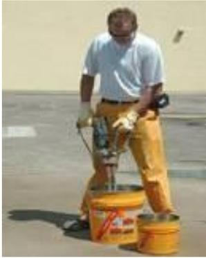
Mezcle ambos componentes con un mezclador de bajas revoluciones (300 – 400 rpm)
