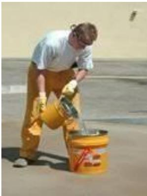
Antes de mezclar, remueva el componente A (resina) y añada todo el componente B (endurecedor)
