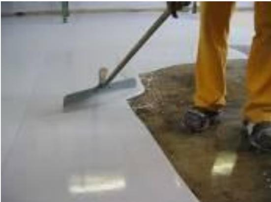
Sikafloor®-381 ECF se vierte y extiende horizontalmente mediante una llana dentada, tanto de pie como arrodillado.
