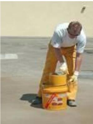
Asegúrese de que el componente B se ha vaciado por completo en el A.
