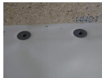
2. Coloque una cinta de enmascarar con un ancho mínimo de 50 mm directamente sobre la fijación para conseguir una superficie lisa para revestir.
