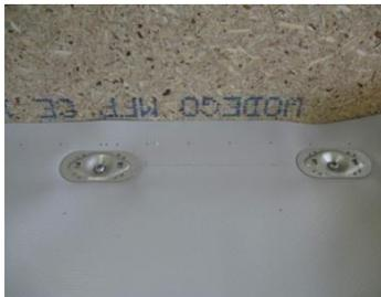
Fijación con Sarnabar y cordón de soldadura de PVC /TPO
