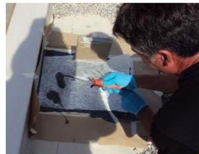
7. El Sika® Reemat se debe embeber completamente y saturar con el Sikalastic®-621 TC. Solape las áreas adyacentes del Sika® Reemat ya colocado 50 mm asegurando suficiente material en estas áreas. Retire la cinta de enmascarar mientras el material está todavía fresco.
