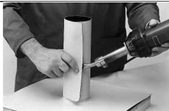
Medir el manguito de la tubería y añada un solape de 30 mm para las soldaduras. Soldar por puntos el manguito.
