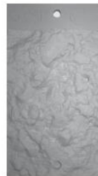
CSP-10 Chorro de hormigón de mano seguido de granallado abrasivo
