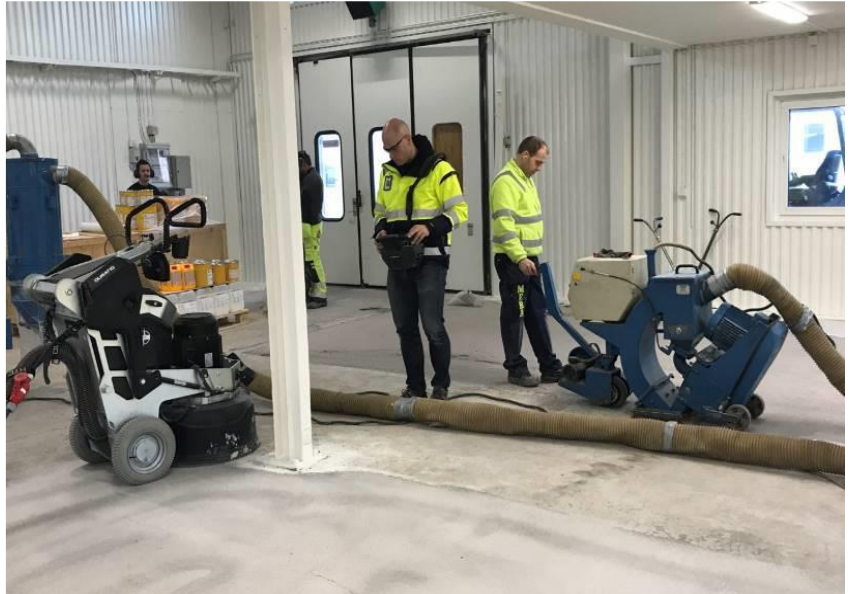
Preparación del soporte: Granallado u otro medio mecánico. P.ej. Blastrac, HTC o similar
