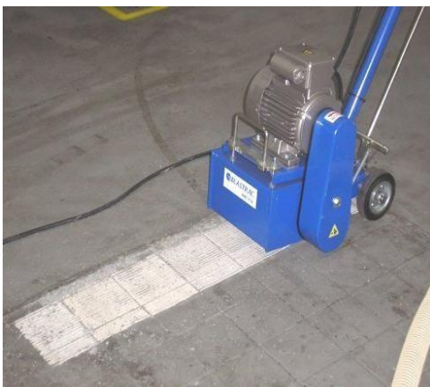
Escarificación del hormigón
