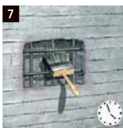
8 Humedecer las superficies del hormigón Saturación de agua de los poros del hormigón
