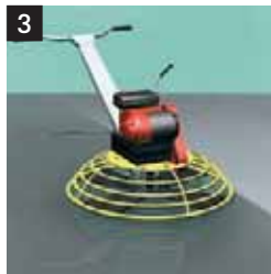
Alisado de la superficie p. ej. con un helicóptero
