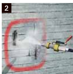
2a Retirada del hormigón Con broca
