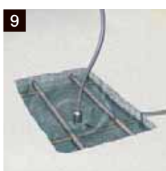
4 Retirada del hormigón Si hay que limpiar por detrás de las armaduras, retirar por lo menos 1-2 cm más
