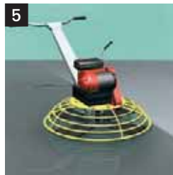
Regularización final p.e. con un helicóptero
