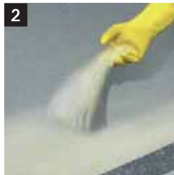
1. espolvoreado* Tan pronto como el hormigón se pueda pisar y que no haya más agua en la superficie, extender uniformemente la mitad de la cantidad prevista del material
