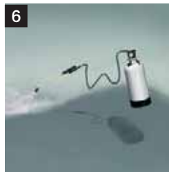
Tratamiento de curado Pulverizar un producto de curado
