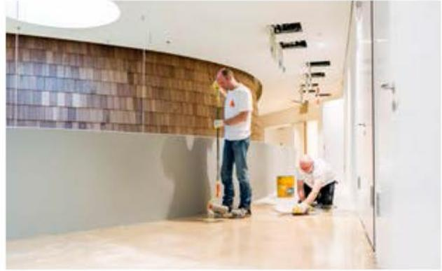
**PASO 2.** Aplicación de una imprimación líquida para asegurar el buen sellado del pavimento. Normalmente, se aplica con una paleta y un rodillo. Puede escogerse el método más adecuado en función de la calidad del subpavimento.
