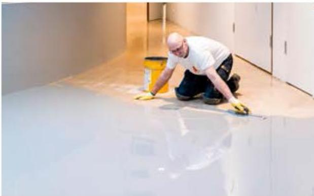
**PASO 3.** Aplicación de los materiales de nivelado en una o varias capas para crear una base continua. Los expertos verterán y distribuirán el material líquido usando espátulas especiales, paletas de mano, allanadoras y rodillos dentados para garantizar que la superficie queda totalmente lisa y homogénea.
