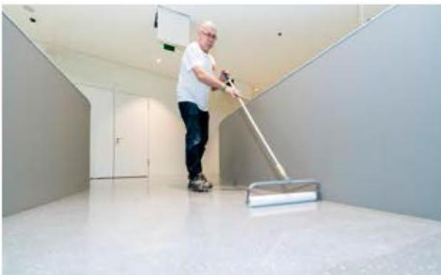
**PASO 5.** El toque final consiste en aplicar una imprimación de acabado transparente o pigmentada. Normalmente, este paso se aplica con rodillo con aerosol. La capa superior asegura el diseño final deseado y añade cualidades de resistencia a la fricción y al uso.
