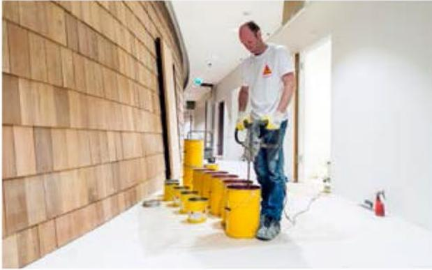
**PASO 1.** Tras inspeccionar y preparar el subpavimento mediante la limpieza (y, en caso necesario, granallar, pulir, lijar y/o nivelar), comenzaremos a mezclar nuestros materiales líquidos.
