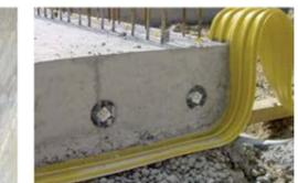
Impermeabilización integral de juntas
