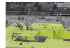
Membranas para impermeabilización de cimentaciones
