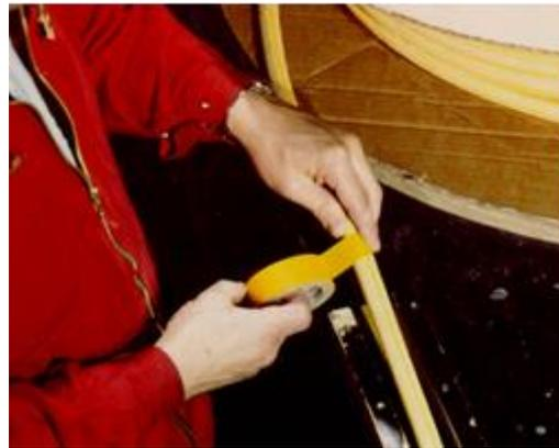
Corte el tubo de inyección *SikaFuko*® VT 1 a la longitud requerida con una tijera cizalla
