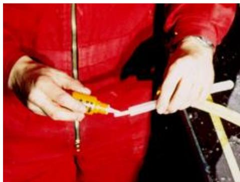
Deslice el tubo de inyección *SikaFuko*® sobre el acople de conexión *SikaFuko*® y encájela para crear una conexión hermética.
