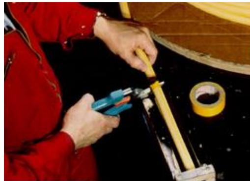
Corte los tubos de salida de PVC, verde y transparente, a las longitudes requeridas. Aplique pegamento en los acoples de conexión para asegurar una correcta unión.
