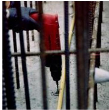
Detalle de fijación del tubo *SikaFuko*®
