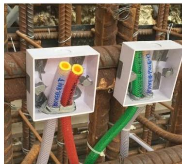
Para evitar cualquier movimiento o deslizamiento, ate los tubos de salida con bridas a las armaduras. La instalación del Sistema *SikaFuko*<sup>®</sup> está lista.
