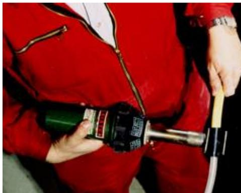
El tubo de inyección *SikaFuko*® estará listo para su instalación tras el cierre de los tubos de salida de PVC con los tapones *SikaFuko*®.
