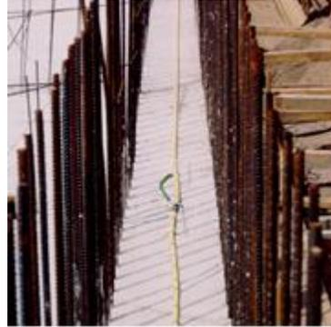
Taladrar agujeros para instalar las abrazaderas del *SikaFuko*®. Es necesario una broca de 6mm de diámetro para las abrazaderas suministradas en la caja del pack.
