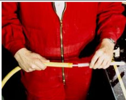
Instale el manguito termorretráctil *SikaFuko*® en el medio, cubriendo la conexión entre el tubo de salida de PVC y el tubo de inyección *SikaFuko*® ...
