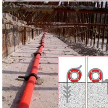
Procedimiento de superposición de los tubos de salida
