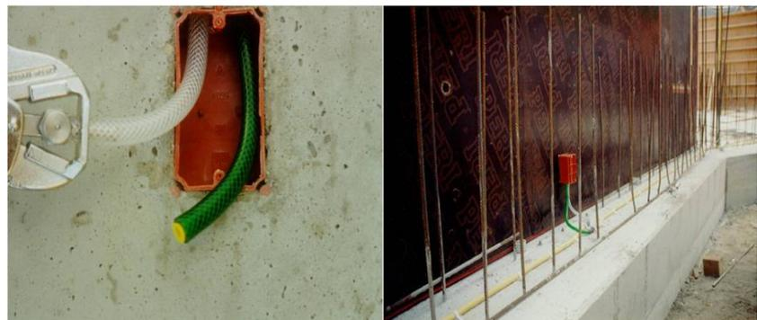
Inserte la pinza *SikaFuko*<sup>®</sup> *Packer-tong* en el extremo del tubo de salida y conecte la bomba a la pinza. El tubo de inyección de la bomba debe conectarse a un acople deslizante (cabeza). Este acople se deslizará sobre el acople de la pinza para conectar y asegurar el tubo a la pinza.
