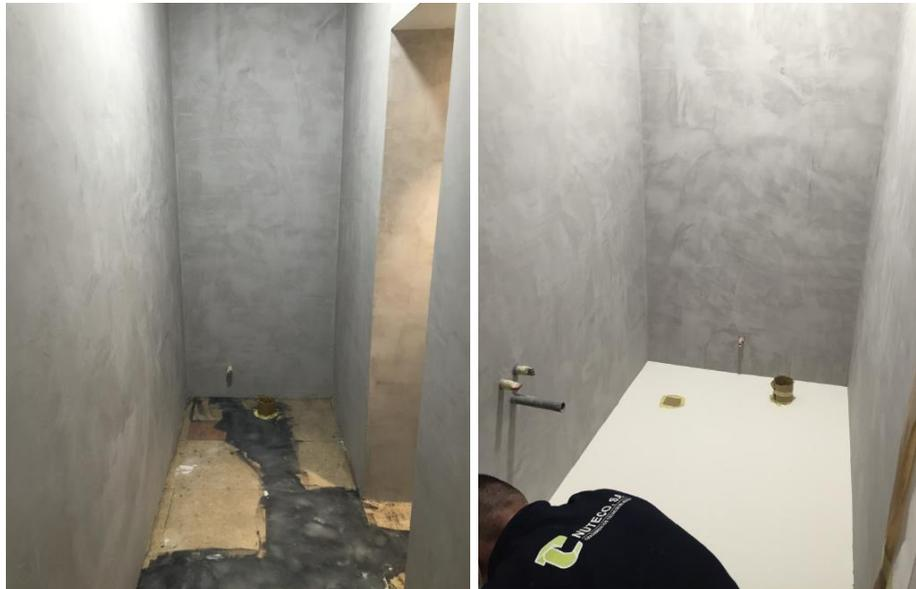
En las fotos se pueden apreciar el revestimiento SIKADecOR 803 NATURE totalmente terminado, incluso con la aplicación del sellado de protección final SIKAFLOOR 304 W. Con este revestimiento final, se consigue una superficie totalmente impermeable y de muy fácil limpieza.
