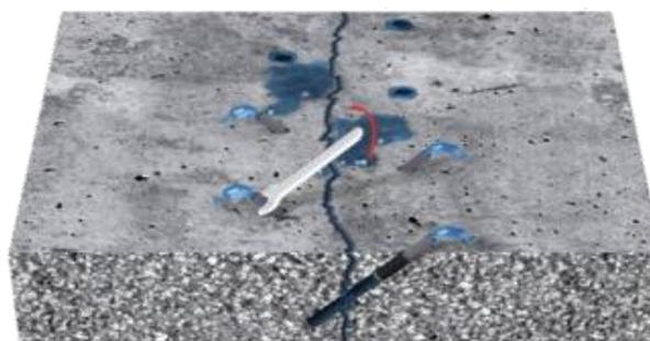
Fijar la boquilla en el primer inyector inferior (inicial).
