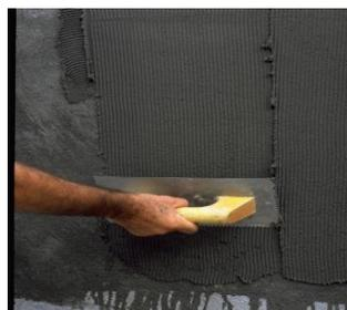
Como dato orientativo, ~ 1,7 Kg / m<sup>2</sup> y mm de espesor (en función de la rugosidad del soporte)
