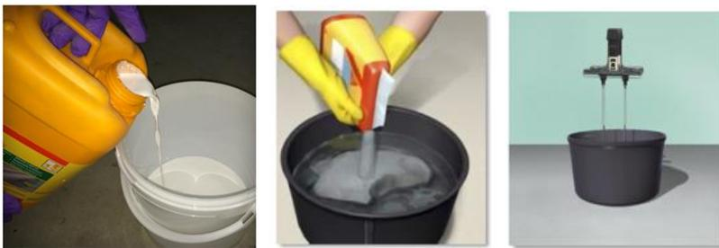
Homogeneizar el componente A antes de su uso. Verter el componente A en el recipiente de mezclado y añadir la parte B lentamente mientras se mezcla. Continuar mezclando durante 2 – 3 minutos hasta que se consiga una consistencia homogénea y sin grumos.
