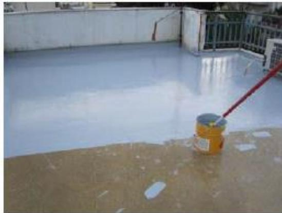
Aplique la primera capa con brocha o rodillo. Mida el área para sacar el volumen correcto del material. Por ejemplo, si se usa 1 l/m<sup>2</sup> por capa cada lata de 15 l cubrirá 15 m<sup>2</sup>. Delimite el área de la cubierta y asegúrese de que se emplea la cantidad necesaria de material dentro de esa área delimitada.
