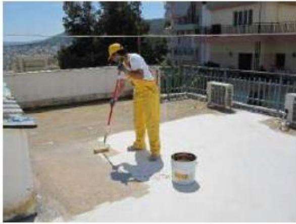
Tras la limpieza y preparación del soporte, aplicar la capa de imprimación o sellado- si es necesario.
