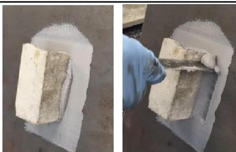
Presione las dos piezas con firmeza para que el exceso de resina salga por los lados. Eliminar el exceso de resina.
