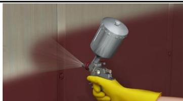
Recubrir la zona circundante con un revestimiento anticorrosivo, especialmente las partes del soporte que se han esmerilado o chorreado en la preparación.
