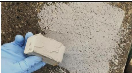
Aplicar una capa de adhesivo sobre la pieza a pegar, de 1 a 5 mm de espesor según la rugosidad de la pieza
