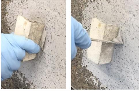
Presione las dos piezas con firmeza para que el exceso de resina salga por los lados. Retire el exceso de resina.
