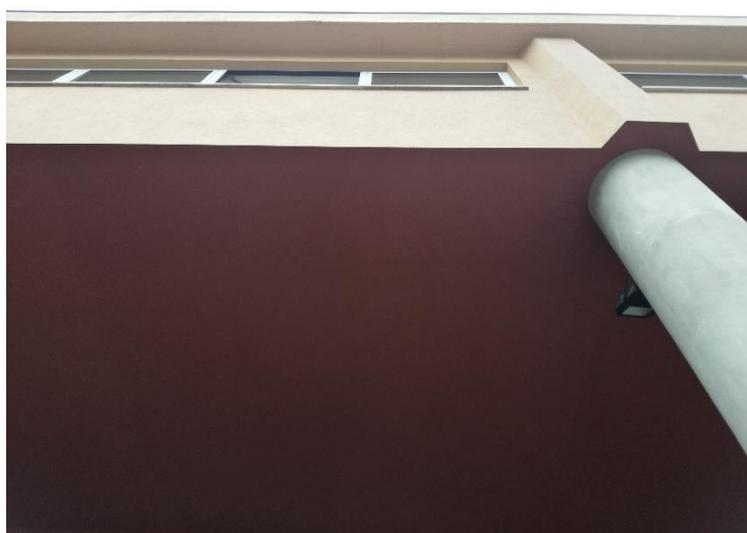
AISLAMIENTO TÉRMICO EN PILARES PARA EVITAR PUENTES TÉRMICOS
