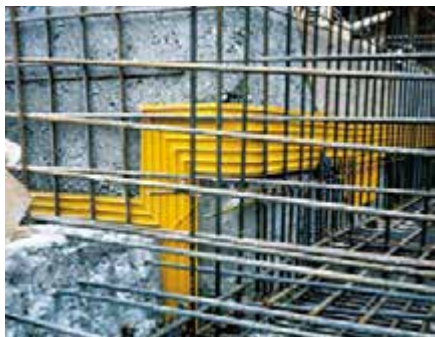
Fig. 8.1.2: Sika Waterbars son cintas flexibles de PVC prefabricado para la impermeabilización de juntas de movimiento y construcción que pueden estar sometidas a baja y alta presión de agua.
