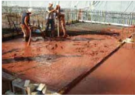
Fig. 8.16.1: La solera, las paredes y el forjado de este edificio médico se construyeron con hormigón pesado utilizando áridos de hematita metálica para garantizar una protección radiológica completa y segura
