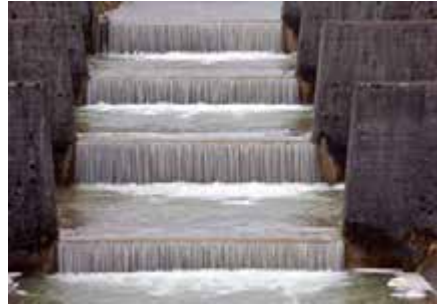
Fig. 8.71: Especialmente en aguas bravas, las superficies de hormigón son sujetas a tensiones adicionales masivas por escombros, bordes afilados y abrasión, así como posibles tensiones de temperatura debido a la exposición a las heladas.
