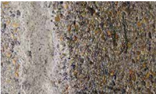
Fig. 8.7.4: Debido a la exposición continua, la película de cemento se erosiona en un paso inicial, y a partir de entonces los áridos pueden ser desgastados, golpeados o lavados de la pasta de cemento endurecido.
