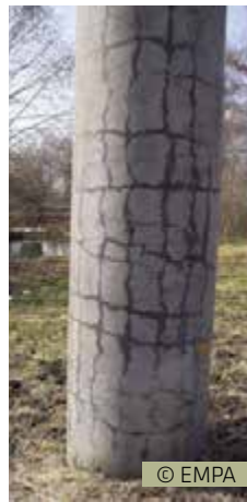
Fig. 8.6.3: La aparición de daños ASR se puede evaluar muy bien en la superficie de hormigón de secado de este pilar de puente. El daño puede aparecer al cabo de años o solo después de décadas.
