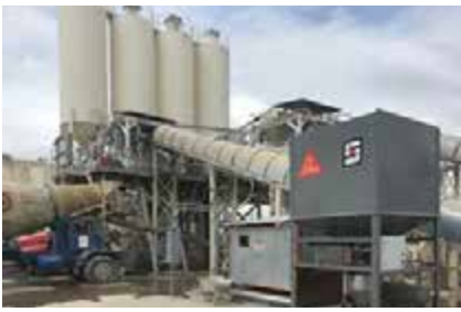
Fig. 8.13.2: El hormigón coloreado exige mucho más que añadir los pigmentos. Desde la planificación hasta la instalación, decisiones fundamentales debe realizarse para que la aplicación sea exitosa y la mayoría de los diversos pasos de producción deben comprobarse y ejecutarse con pericia. La imagen muestra un dispensador de color granular Sika Scofield® en una planta hormigonera.
