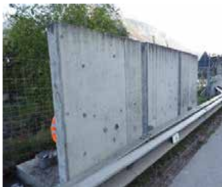
Fig. 8.2.4: Medición de potencial en un muro de contención a lo largo de una carretera con mucho tráfico con alto uso de sal fundente, después de menos de 10 años de exposición. Cuanto más oscura sea la coloración, mayor será el potencial de corrosión.
