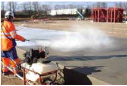
Fig. 8.10.2: La cobertura inmediata o el curado de superficies de hormigón expuestas a los elementos es el paso más crucial para la protección de dichas superficies
