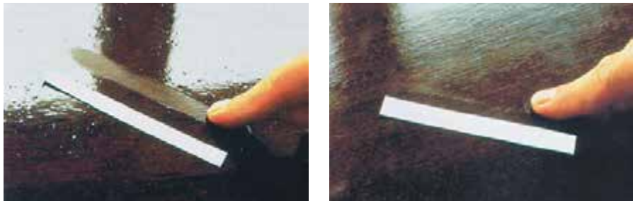
Fig. 10.1.2: Prueba de dedo de la aplicación correcta de desencofrante (izquierda: demasiada cantidad / derecha: buena aplicación de desencofrante)
