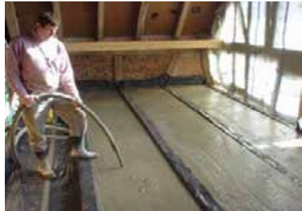
Fig. 8.15.1: Las resistencias a la compresión que se pueden obtener están siempre vinculadas a la densidad de los materiales. El nivel de esta correlación se puede alterar por la calidad de los áridos. Como es de esperar, si se genera el menor peso volumétrico mediante aire ocluido, el hormigón dará como resultado una resistencia muy baja. Las arcillas expandidas también pueden dar muy buen desarrollo de resistencia a bajas densidades, de aproximadamente 1500 kg/m 3 . Resultando en un peso volumétrico del hormigón inferior a 2000 kg/m 3 .
