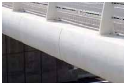
Fig. 8.9.4: Los componentes de construcción altamente tensionados, como pilares y vigas, están hechos de hormigón de alta resistencia. La alta resistencia a las influencias externas también hace que el hormigón de alta resistencia sea un recubrimiento protector ideal para los elementos de construcción expuestos.
