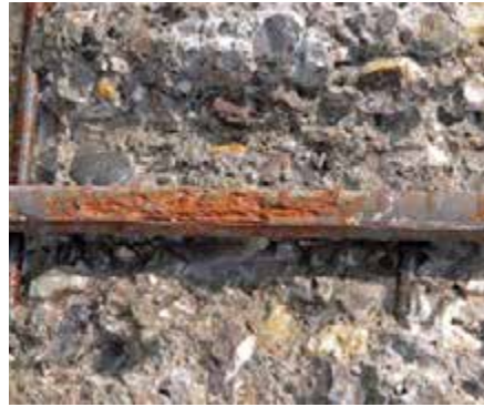
Fig. 8.2.1: Daño a la estructura de hormigón debido a un recubrimiento de hormigón insuficiente y baja calidad del hormigón
