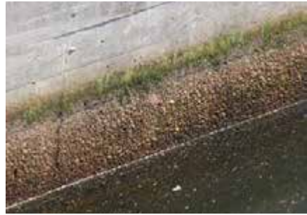
Fig. 8.8.1: Se observa una fuerte degradación y daños en el hormigón estructural, especialmente en la zona de salpicaduras de agua de las cuencas de tratamiento biológico
