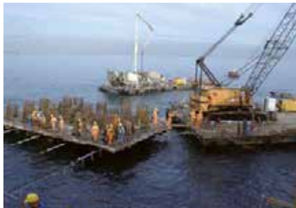
Fig. 8.14.1: Cuando se utiliza hormigón bajo el agua, la colocación y las condiciones de trabajo son muy complejas, por lo cual los hormigones a menudo también necesitan un tiempo de trabajo prolongado.
