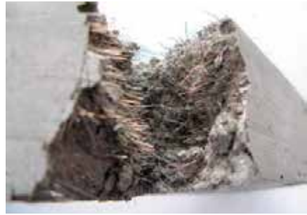
Fig. 8.9.1: El hormigón de alta resistencia y sobre todo de ultra alto rendimiento (UHPC) suele reforzarse con fibra. Dependiendo de los requisitos, las fibras sintéticas y/o de acero se emplean en gran cantidad
