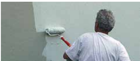
Fig. 8.8.2: La resistencia del hormigón al ataque químico es limitada, los recubrimientos protectores se utilizan a menudo para la protección externa. Los recubrimientos protectores a base de resina epoxi se aplican sobre toda la superficie tras el reperfilado de la superficie de hormigón con mortero de reparación resistente a sulfatos mejorado con material sintético
