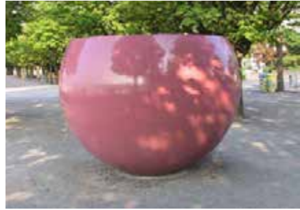
Fig. 8.12.1: Debido al desarrollo del HAC (hormigón autocompactante), el potencial de diseño y construcción es ahora casi ilimitado, sumado a las nuevas tecnologías de encofrados especiales y a la incorporación de aditivos para hormigón específicos, se pueden conseguir acabados de alta calidad, incluso en las zonas más difíciles.
