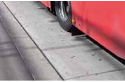
Fig. 8.7.2: Las carreteras de hormigón y otras áreas de acceso público, especialmente aquellas que experimentan grandes volúmenes de tráfico o cargas concentradas, están sujetas a altas cargas mecánicas y fuerte abrasión, a menudo resultando en el riesgo de una superficie lisa y resbaladiza.
