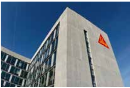
Fig. 8.12.2: Con una amplia variedad de encofrados y tratamientos disponibles, se puede crear casi cualquier acabado de hormigón, incluidos liso espejo tablero de madera liso u otros patrones, por ejemplo, árido expuesto, etc.
