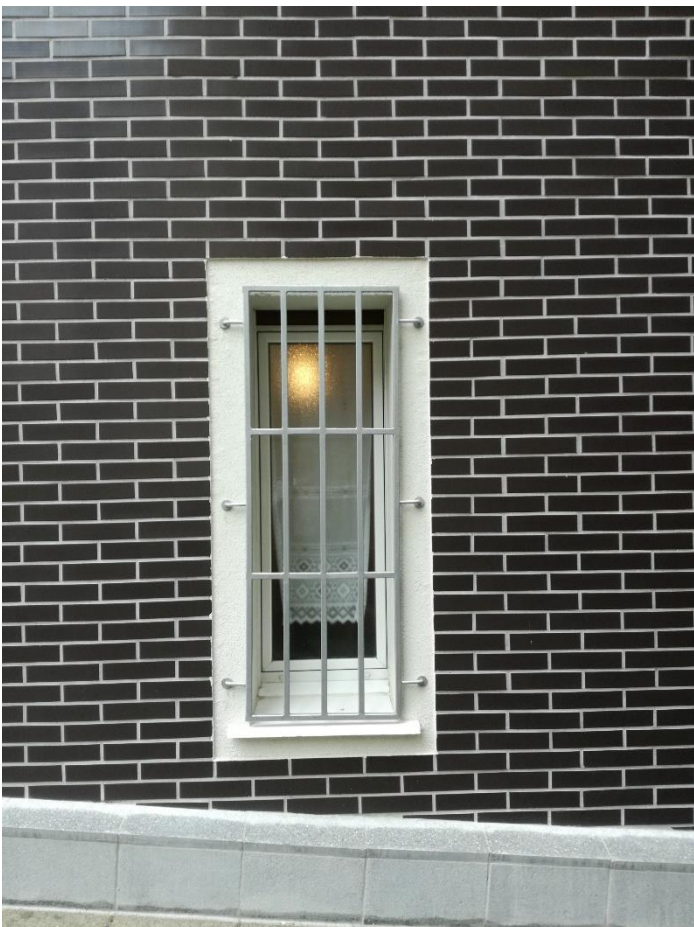
FACHADA TRASERA – Acabado cerámico combinado con acabado en mortero acrílico SikaThermocoat 5 TF
