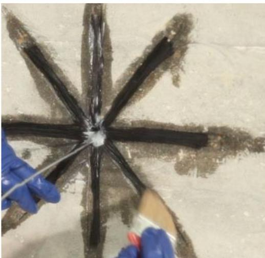
Separe las fibras en 8 partes de igual densidad de fibras y presiónelas contra el soporte previa impregnación. Elimine la aguja de tejer, con cuidado de no extraer el conector.
