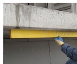
En la superficie del soporte se practicarán ocho ranuras en forma de estrella tal y como se observa en la imagen. Las rendijas deben tener un mínimo de ancho de 8-10 mm y 5-10 mm de profundidad respectivamente. Después del corte, las rendijas deben ser limpiadas de polvo y otros residuos mediante soplado o aspirado.
