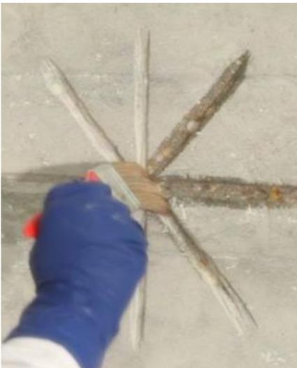
Impregne la superficie del hormigón empleando una brocha.
