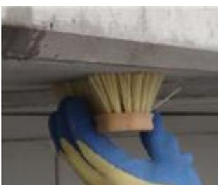
La superficie final debe quedar lisa, seca y libre de hormigón dañado y de cualquier otro contaminante como polvo, partículas extrañas, lechada de cemento, aceite, grasa, revestimientos de superficie, compuestos de curado, ceras e impregnaciones, etc., que podrían afectar negativamente o inhibir la unión del sistema de refuerzo al hormigón.
