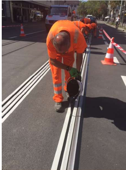
Fotografía 2: Aplicación del Sikaflex 406 KC directamente del envase
