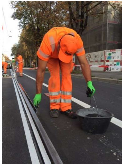
Fotografía 3: espolvoreo de arena de cuarzo sobre el Sikaflex-406 KC
