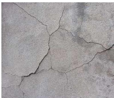
Se deberá comprobar la adherencia al cerramiento de los morteros hidráulicos y revestimientos cerámicos existentes. En la comprobación, toda zona que presente fisuraciones por fallo de adherencia, o sonido hueco al golpear, se deberá eliminar y reparar.
