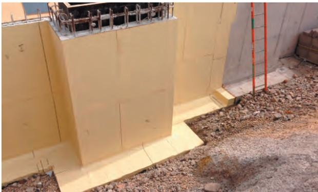
Muro de contención a doble cara con talón: la estructura completa se sella con SikaProof® P.
