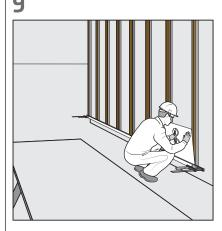
Coloque el panel en la posición deseada, al principio sin que toque la cinta, y después presione firmemente hasta que toque la cinta del fijación SikaTack® Panel 3
