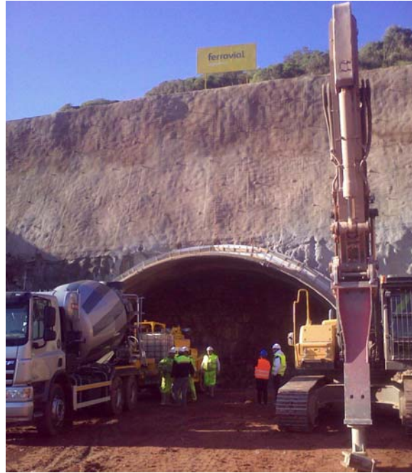
Foto 3.- Detalle del emboquille del túnel y la colocación de los primeros cuadros
