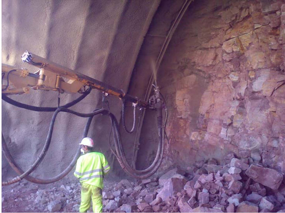
Foto 2.- Hormigón proyectado en el túnel empleando un robot Sika PM 500
