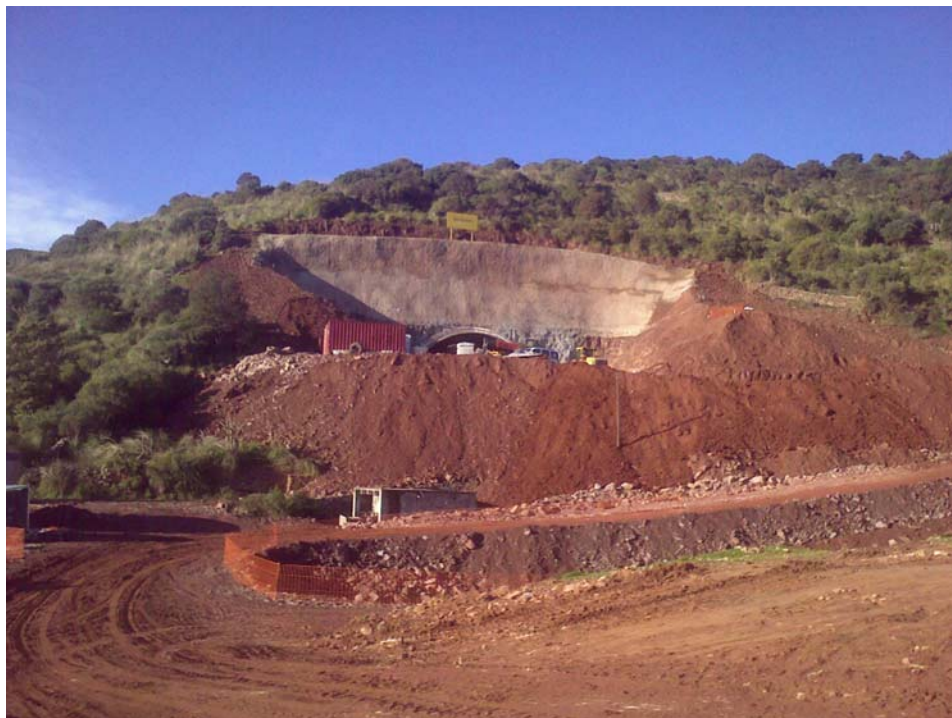
Foto 1.- Detalle del emboquille del túnel de la Variante de Ferreries
